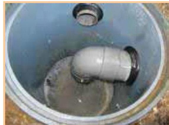
排水マスの清掃
