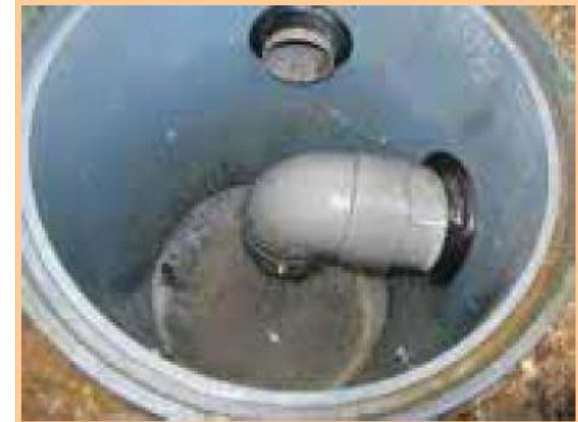
排水マスの清掃
